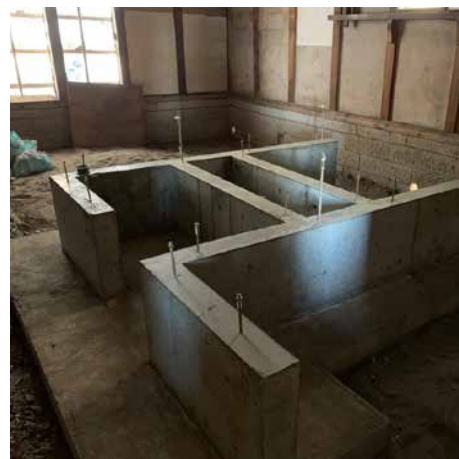
明治蔵の内部に基礎を新設 耐震補強
