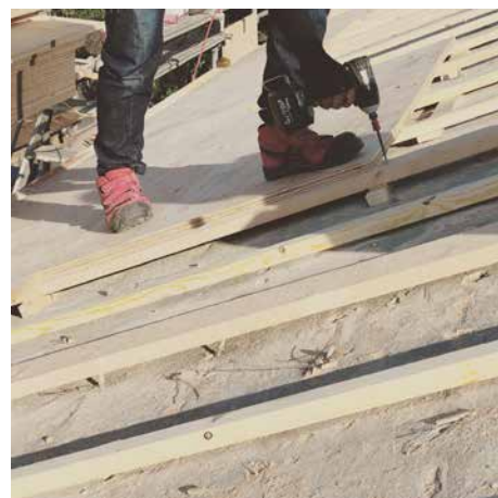
土蔵の屋根補修 木下地を長ビスで垂木へ固定
