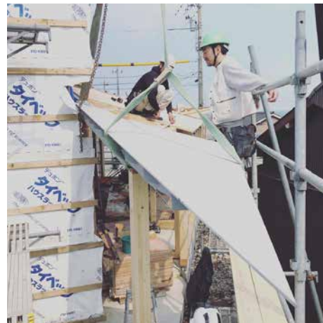
屋根先端部は鉄骨・鉄板による補強を行った
